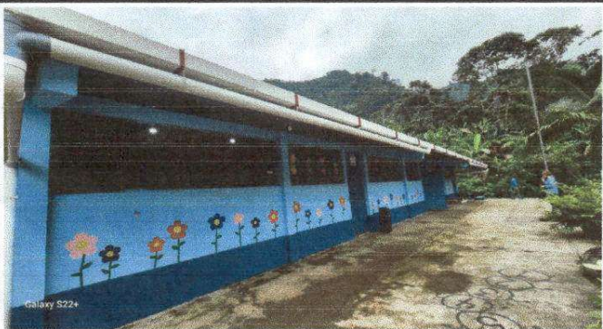
Foto 3: Pintura de muros interiores y exteriores del módulo I.
