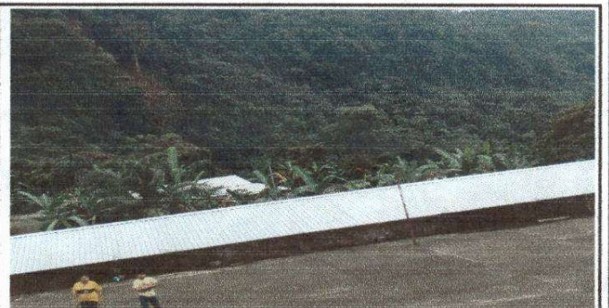
Foto 6: Sustitución de lámina troquelada calibre 26 del módulo I.
