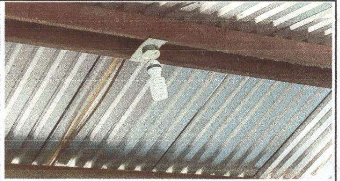
Foto 4: Se Sustituyo cableado y ducto eléctrico en aulas del módulo I y Módulo II.
